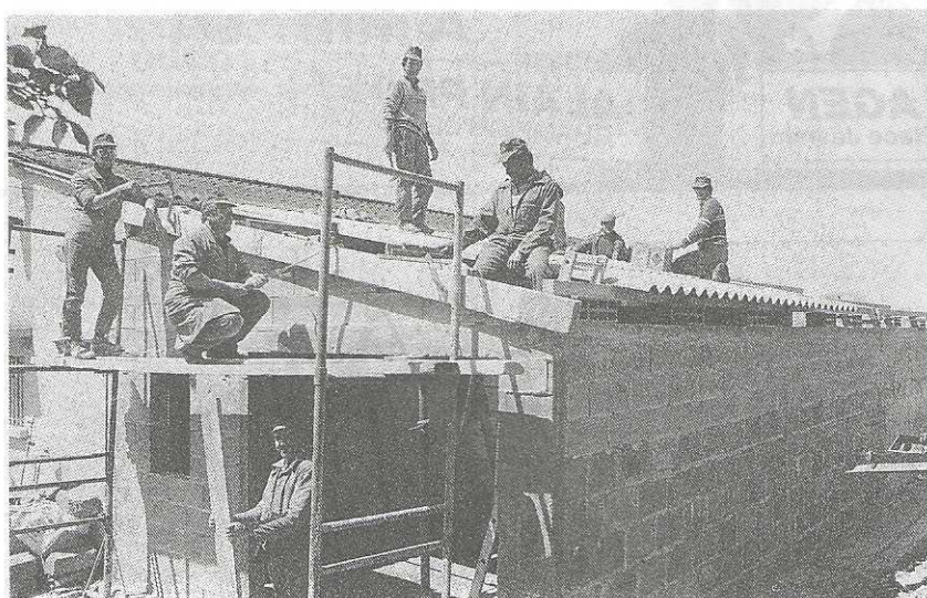
Pendant les travaux (de l'ardeur Sapeur !).
