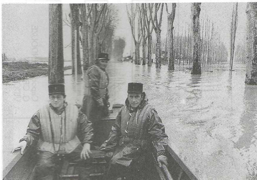
La Nationale 113, Lieudit "Robinson" à Tonneins.
