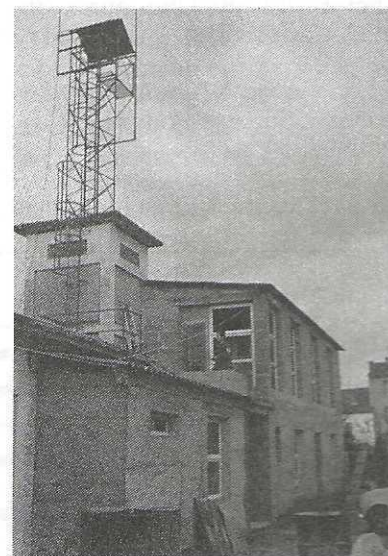
La construction en cours de finition.
